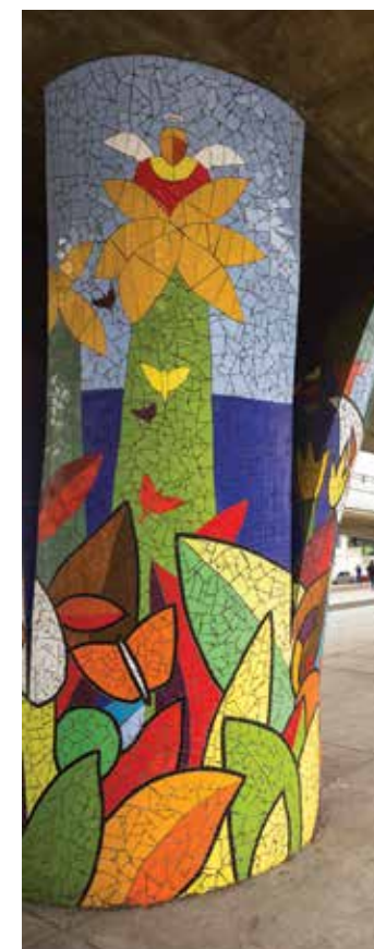
Detalle de un pilar.
